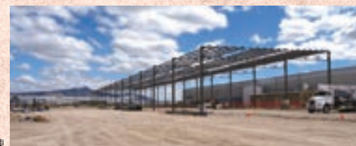
建設中の新棟
